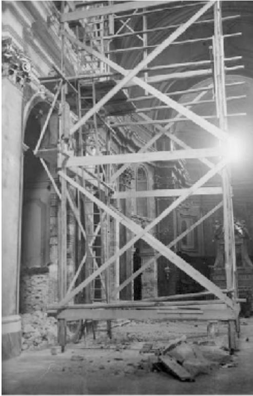
Marzo 1954 - I lavori all'interno della Collegiata
